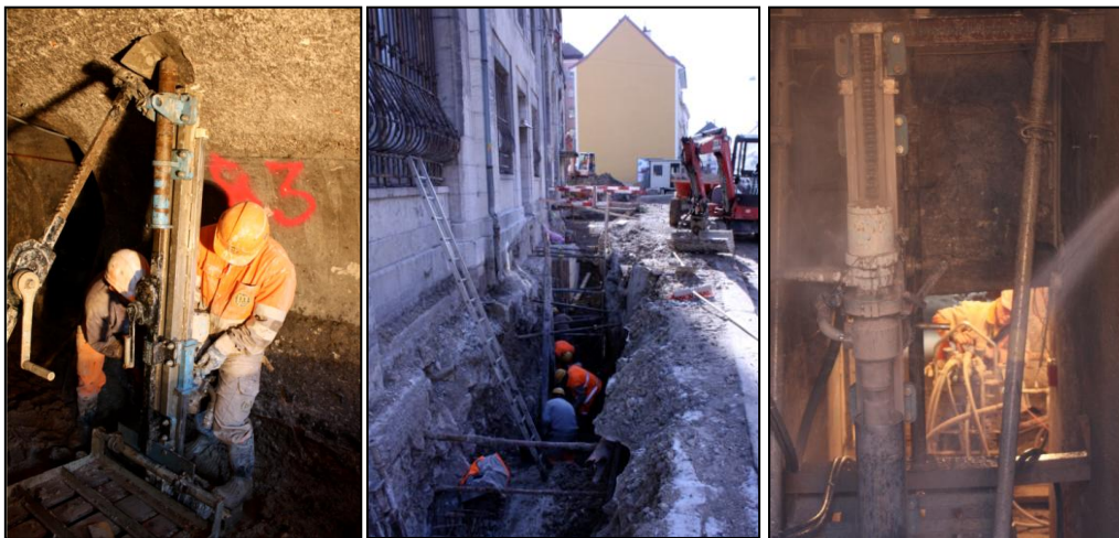
D'une ampleur particulièrement importante, la réhabilitation de l'Ancienne poste a nécessité des adaptations et des solutions quotidiennes.
