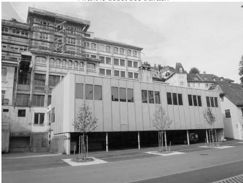
Avant le début des travaux
