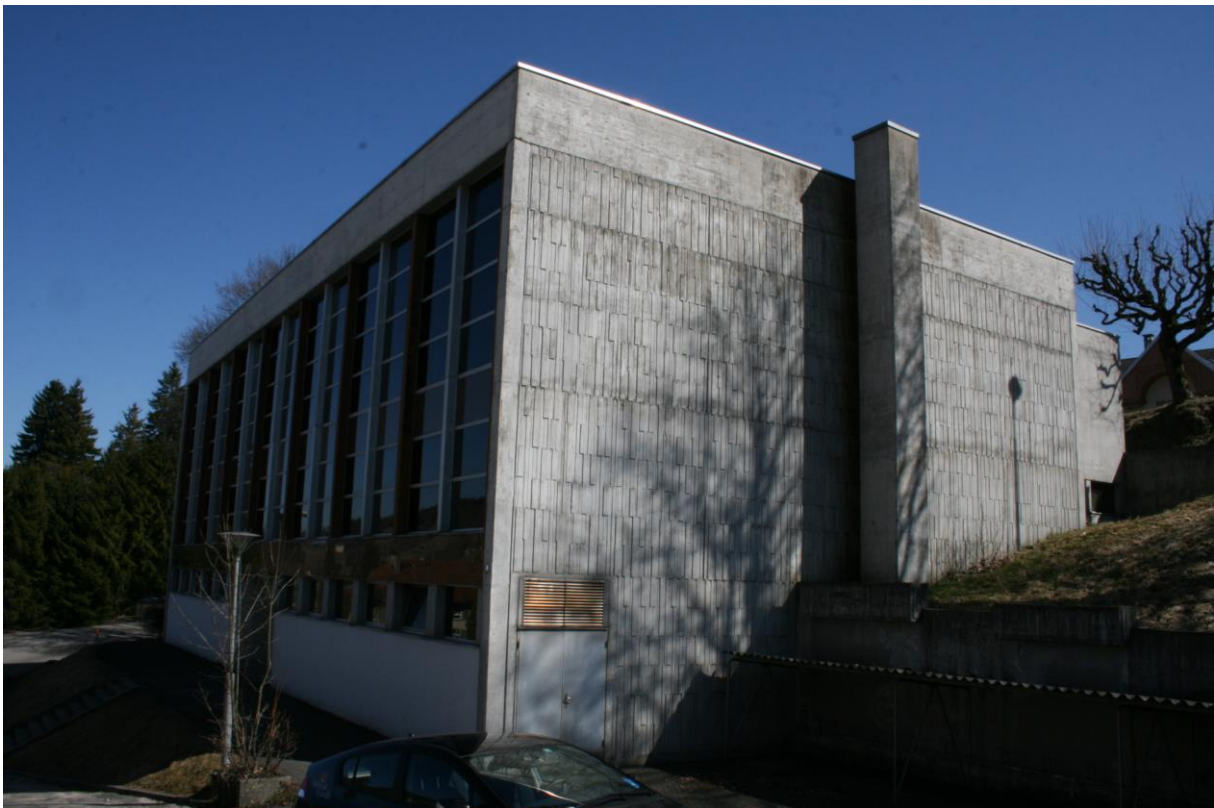
Façades nord et ouest
