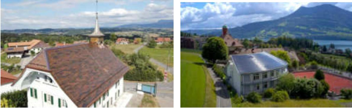
Figure 20 : Exemples d'installations solaires intégrées de modules colorés de format adapté à la trame de la toiture original (source : freesuns)
