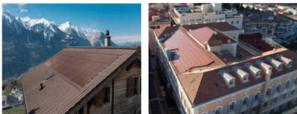
Figure 17 : Exemple d'installation solaires avec modules colorés de format standard permettant une meilleure intégration architecturale dans la toiture existante (Source : Luigi Pozzoli, Bisol spectrum)
