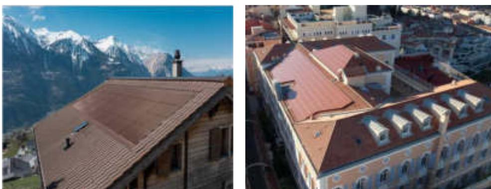
Figure 17 : Exemple d'installation solaires avec modules colorés de format standard permettant une meilleure intégration visuelle dans la toiture existante ou une limitation de l'impact visuel en version apposée (Source : Luigi Pozzoli, Bisol spectrum)
