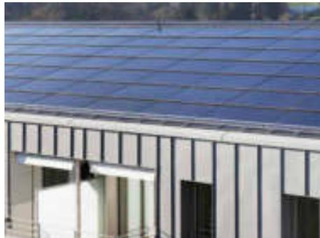
Figure 18 : Exemples d'installations solaires intégrées en toiture avec des modules noirs de formats standards (source : Eternit, Ernst Schweizer AG)
