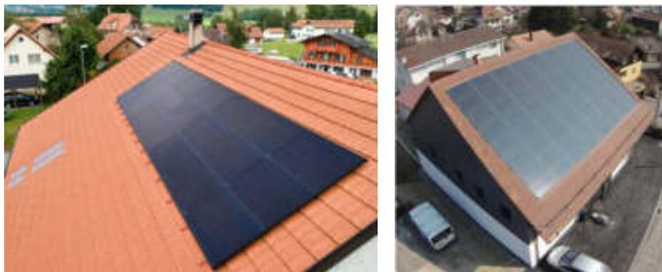
Figure 16 : Exemples d'installations solaires de modules noirs apposés sur une toiture en pente
