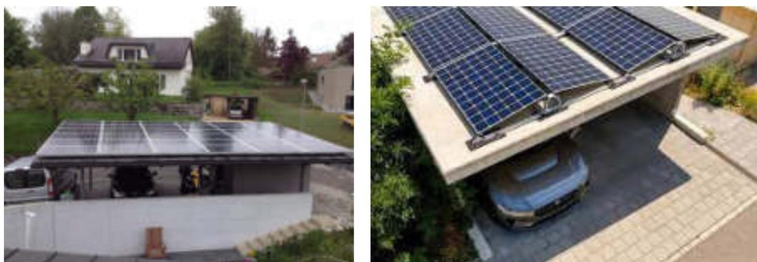
Figure 22 : Exemples d'installations solaires intégrées de modules colorés de format adapté à la trame de la toiture original
