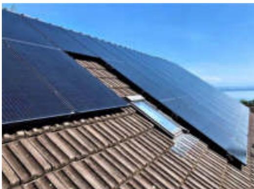
Figure 13 : Exemple d'une installation BAPV à Cormondrèche dans le Canton de Neuchâtel (source : stg-energy)
