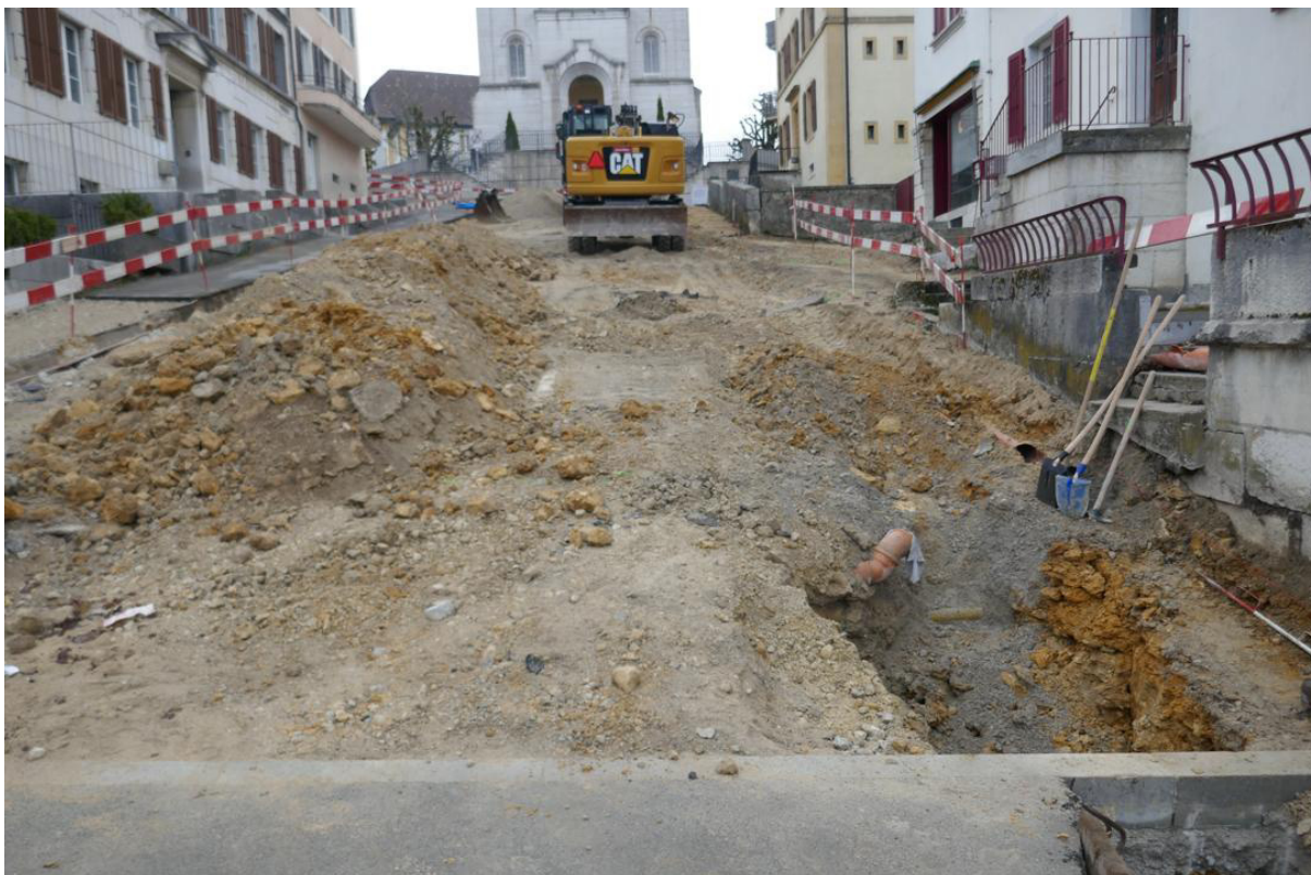
Figure x : Travaux souterrains sous La rue du Collège aux Brenets
